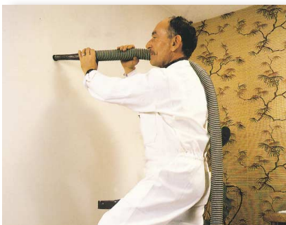
Inyección en cámara y plenum ISOVER
